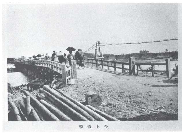
工兵により架けられた馬入川仮橋
