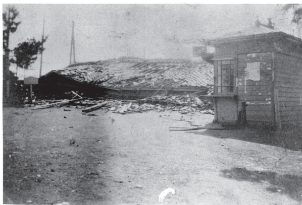
倒壊した茅ヶ崎駅の駅舎
